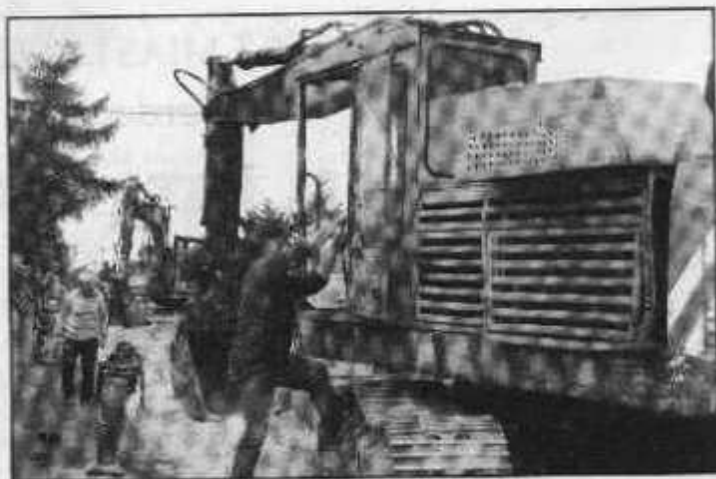
Budowa kanalizacji na ul. Średniej
