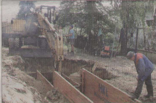
Na ul. Granicznej trwa budowa kanalizacji.
